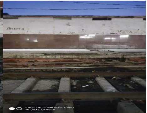
चित्र 4.4: गया (पूमरे) पर प्लेटफार्म सं. 02/03 पर ट्रैक को क्षति पहुंचाते हुए सार्वजनिक शौचालय का कचरा/पानी
