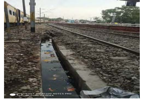
चित्र 4.2: गया (पूमरे) पर गिट्टी से रूकावट वाले प्लेटफार्म सं.5/6 के गंदे नाले
