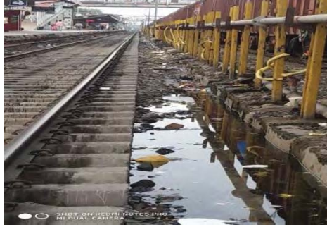
चित्र 4.1: गया (पूमरे) पर गिट्टी से रूकावट वाले प्लेटफार्म सं. 03/04 के गंदे नाले
