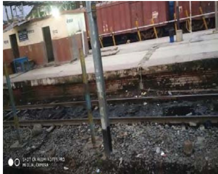
चित्र 4.3: गया (पूमरे) पर प्लेटफार्म सं. 04/05 पर ट्रैक को क्षति पहुंचाते हुए सार्वजनिक शौचालय का कचरा/पानी
